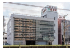
本社第二ビル
